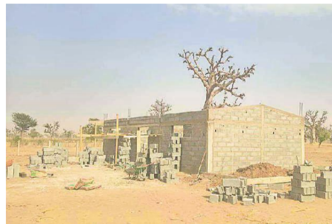
La nuova scuola in costruzione che sarà inaugurata entro l'estate
